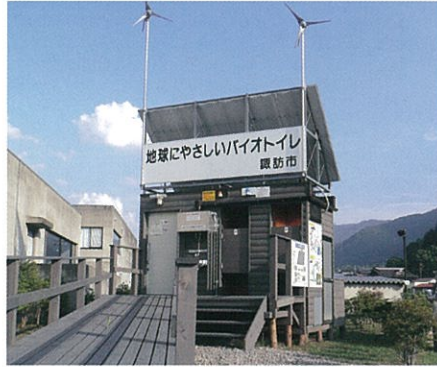
長野県 諏訪市 ガラスの里敷地内 MDBR-MK3-L型-SP-FWP-HWR-JSS-SBS-発電機-尿タンク300L×3
