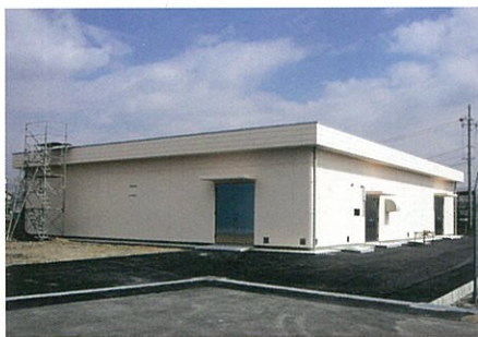
兵庫県 伊丹市 国土交通省大阪空港事務所 第1ASR/SSR・TX局舎 M型×1台
