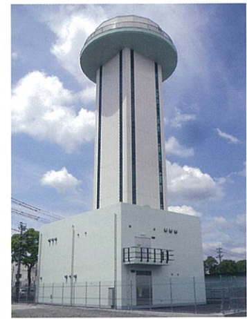
鹿児島県 福岡管区気象台 鹿児島空港気象DR局舎 M型×1台
