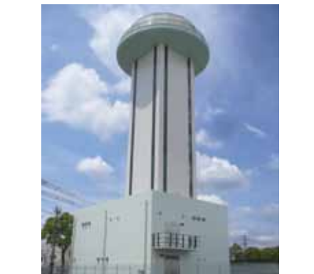
鹿児島県 福岡管区気象台 鹿児島空港気象DR局舎 バイオR21-M型-SB-KB×1台
