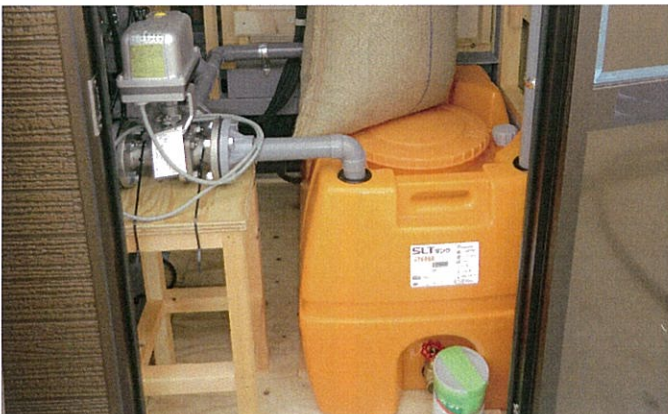
MDBR-PK2B-L型-SB-KB-SP-HWR-JSS-SBS-尿タンク200L-自動給水ポンプ
