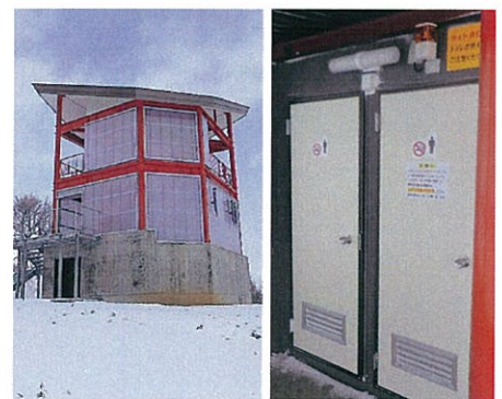
新潟県 湯沢町 ガーラ湯沢スキー場 MDBR-PK1-L型-SB-KB-JSS-SBS 2基 MDBR-PK2A-L型-SB-KB-JSS-SBS 1基 尿タンク300L×2・200L×1
